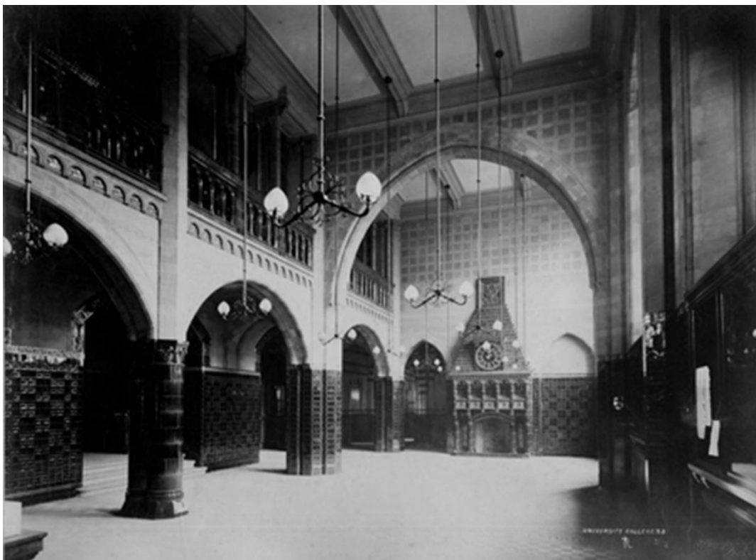
Le grand hall d'entrée, vers 1892
