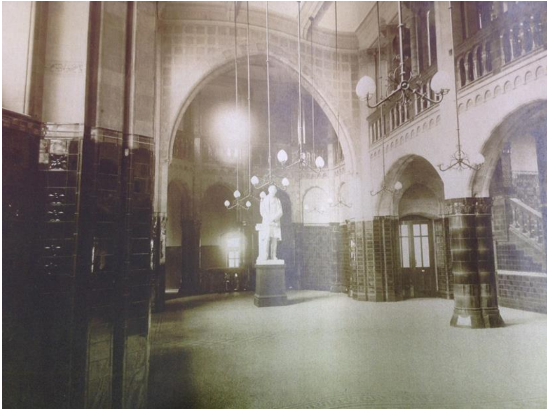
Le grand hall d'entrée, vers 1892
